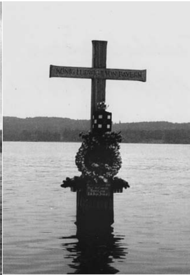
Teakholzkreuz 1961 zum 75. Todestag, 1986 abgesägt, heute in Pleinting
